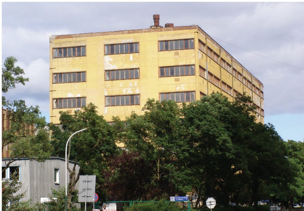
Budynek gdyńskiego Dalmoru, stan z 2012 r. Fot. Wikimedia Commons
