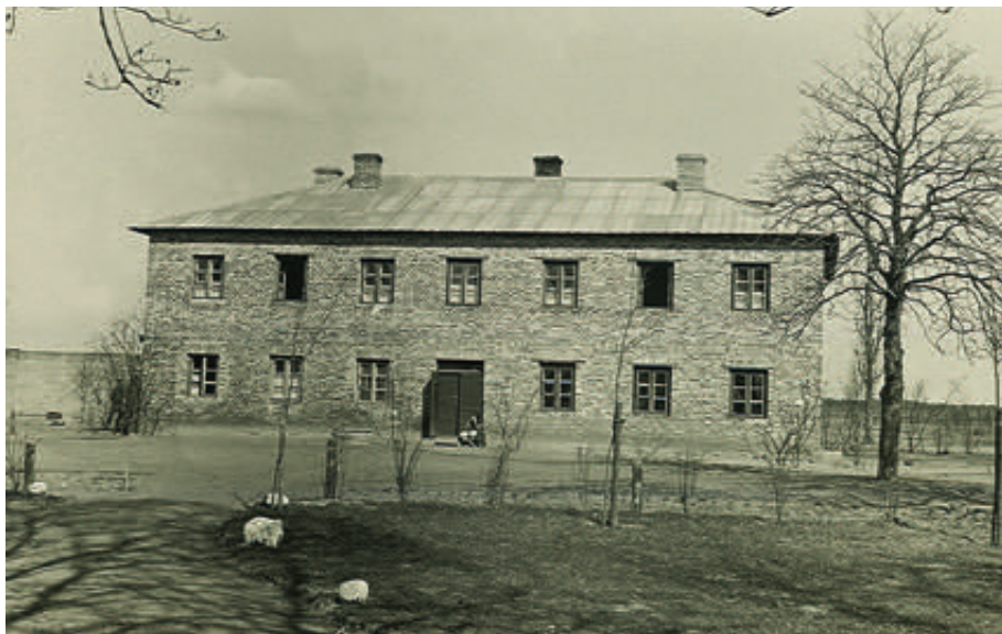
Dom sióstr w Mołodowie, przerobiony z kurnika. Fot. Archiwum Zgromadzenia Sióstr Urszulanek SJK
