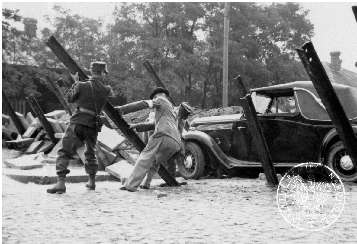
Budowa zapory przeciwczołgowej na jednej z ulic lewobrzeżnej Warszawy, 10 września 1939
