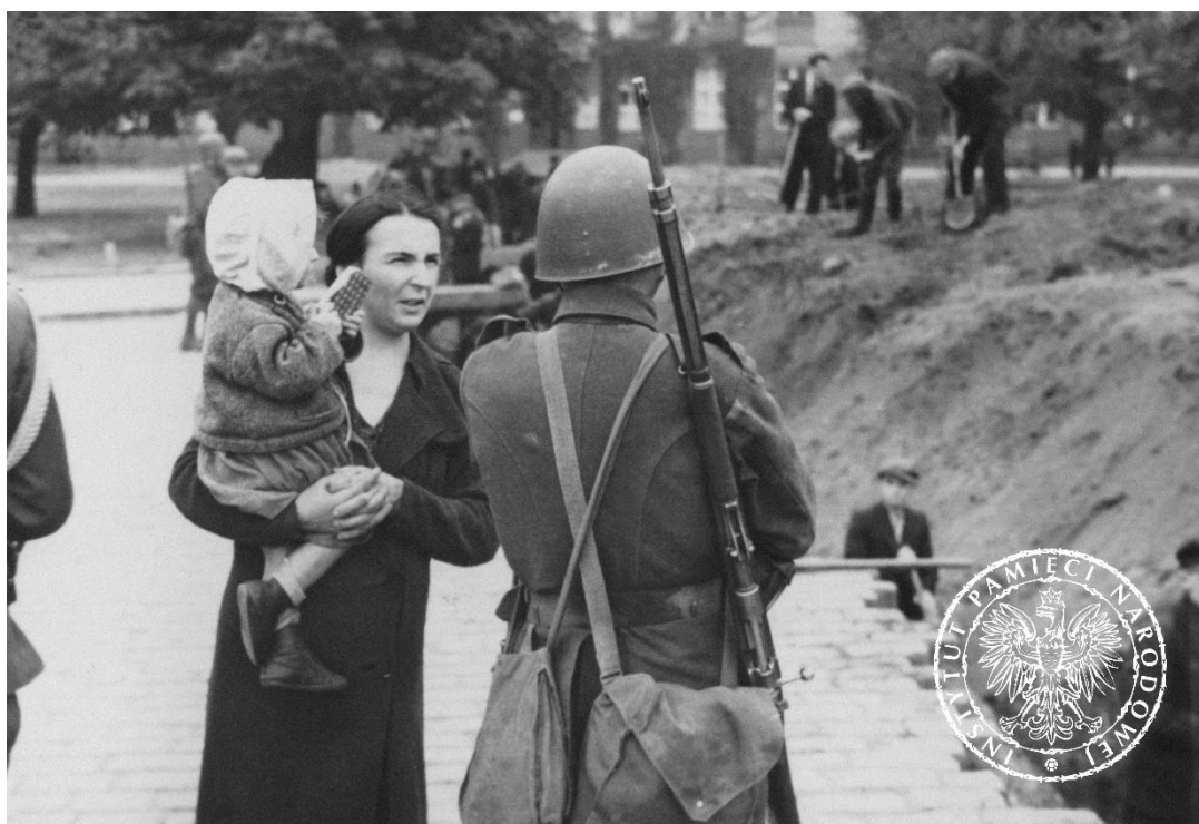
Budowa umocnień na Pradze na drodze prowadzącej do mostu przez Wisłę. Warszawa, 7 września 1939
