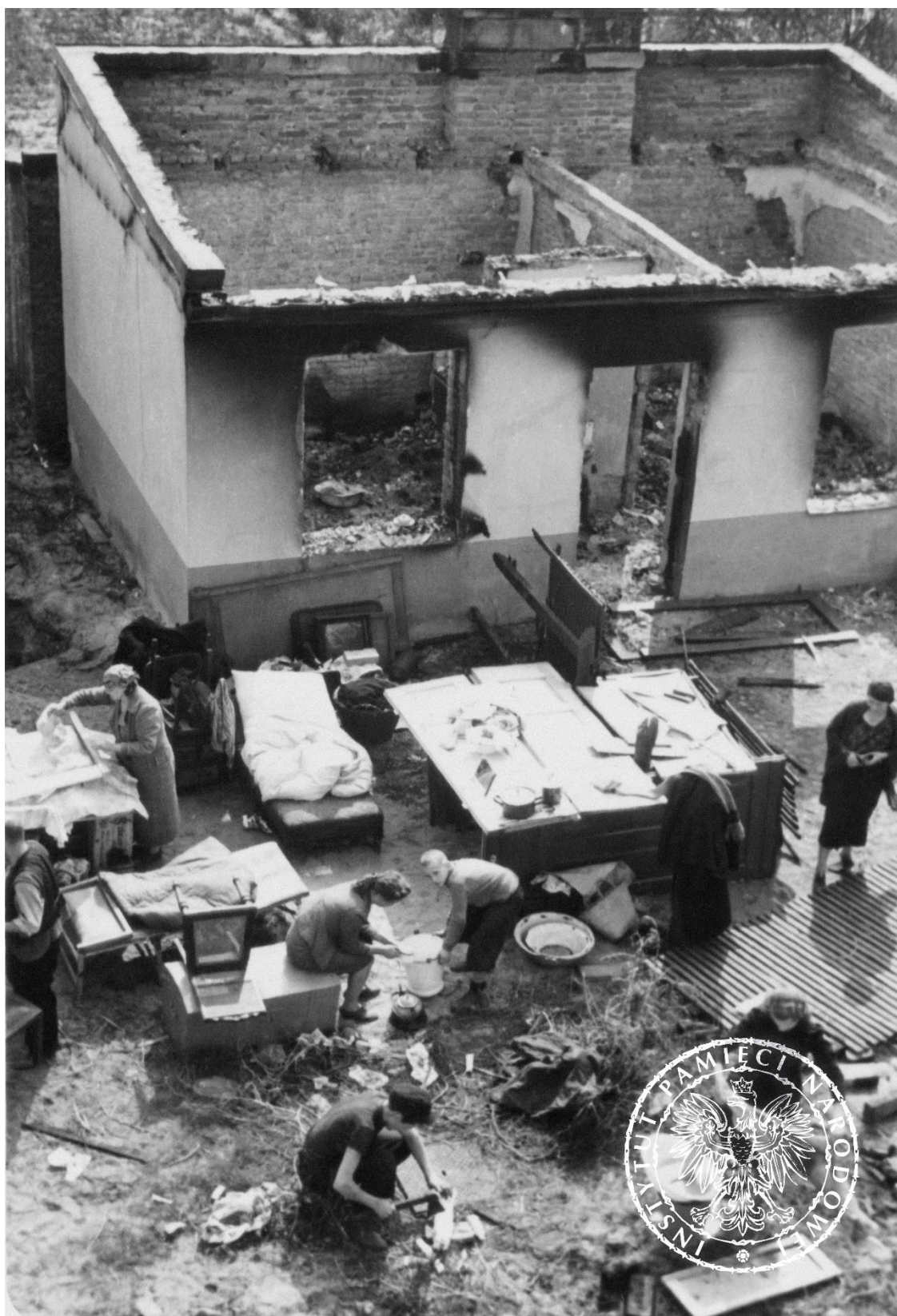
Mieszkańcy zniszczonego domu przy ulicy Julianowskiej w Warszawie z resztkami uratowanego dobytku, wrzesień 1939
