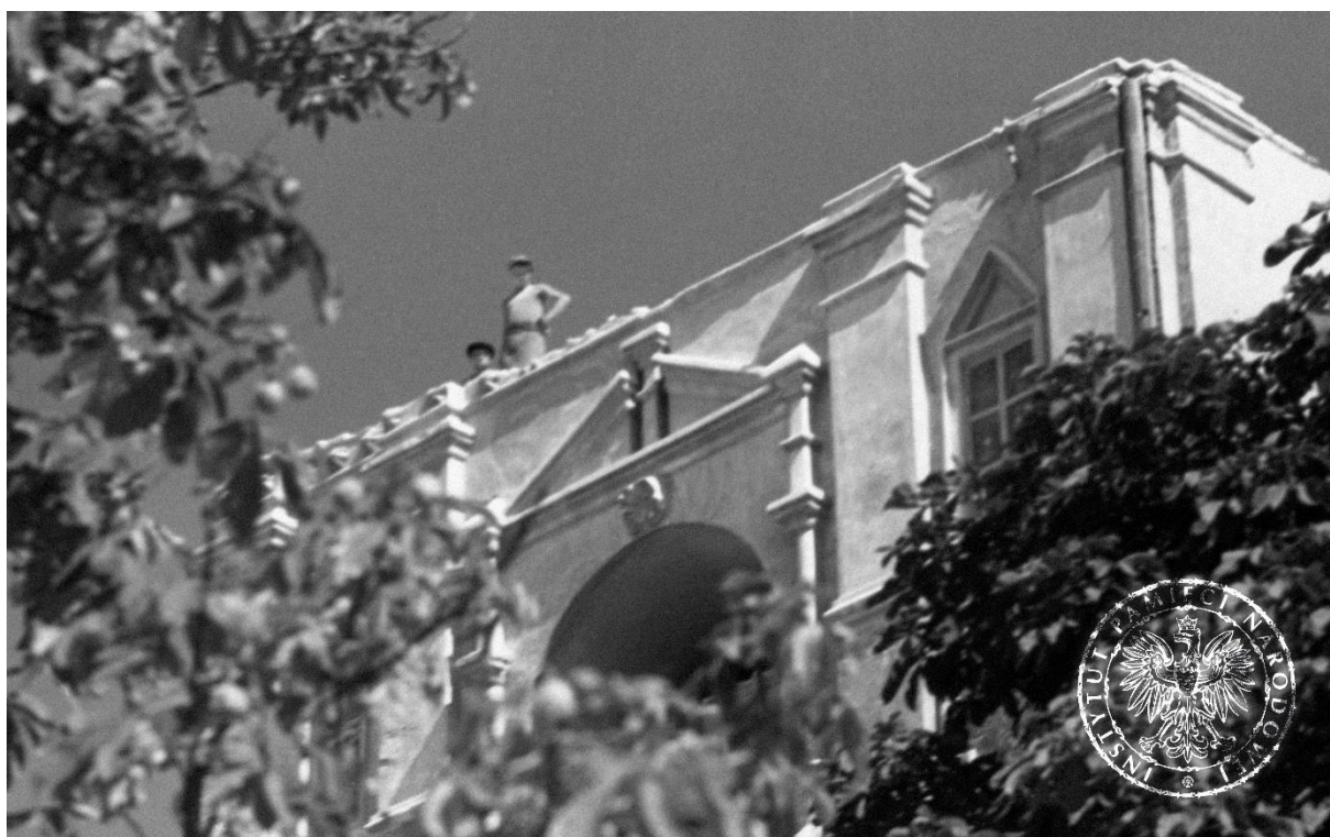
Rozbiórka dzwonnicy Monasteru św. Michała Archanioła o Złotych Kopułach. Pozostałości konstrukcji monasteru wysadzono latem następnego roku. Część zdjętych ze ścian fresków i mozaik została wywieziona do Rosji. Kijów, 1936
