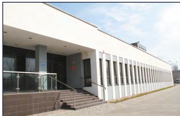
Siedziba Centrali BUiAD w Warszawie, ul. Kłobucka 21
