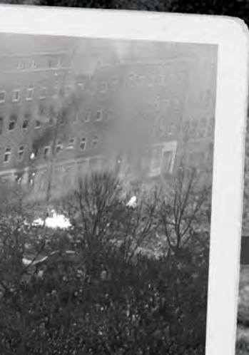
Manifestanci uniemożliwili strażą pożarną gaszenie gmachu partii. Nie straszyli jednak zabezpieczenia sąsiednich budynków mieszkalnych. Placący gmach KW PZPR, 17 grudnia 1970 r. Fot. Maciej Jasiecki.
