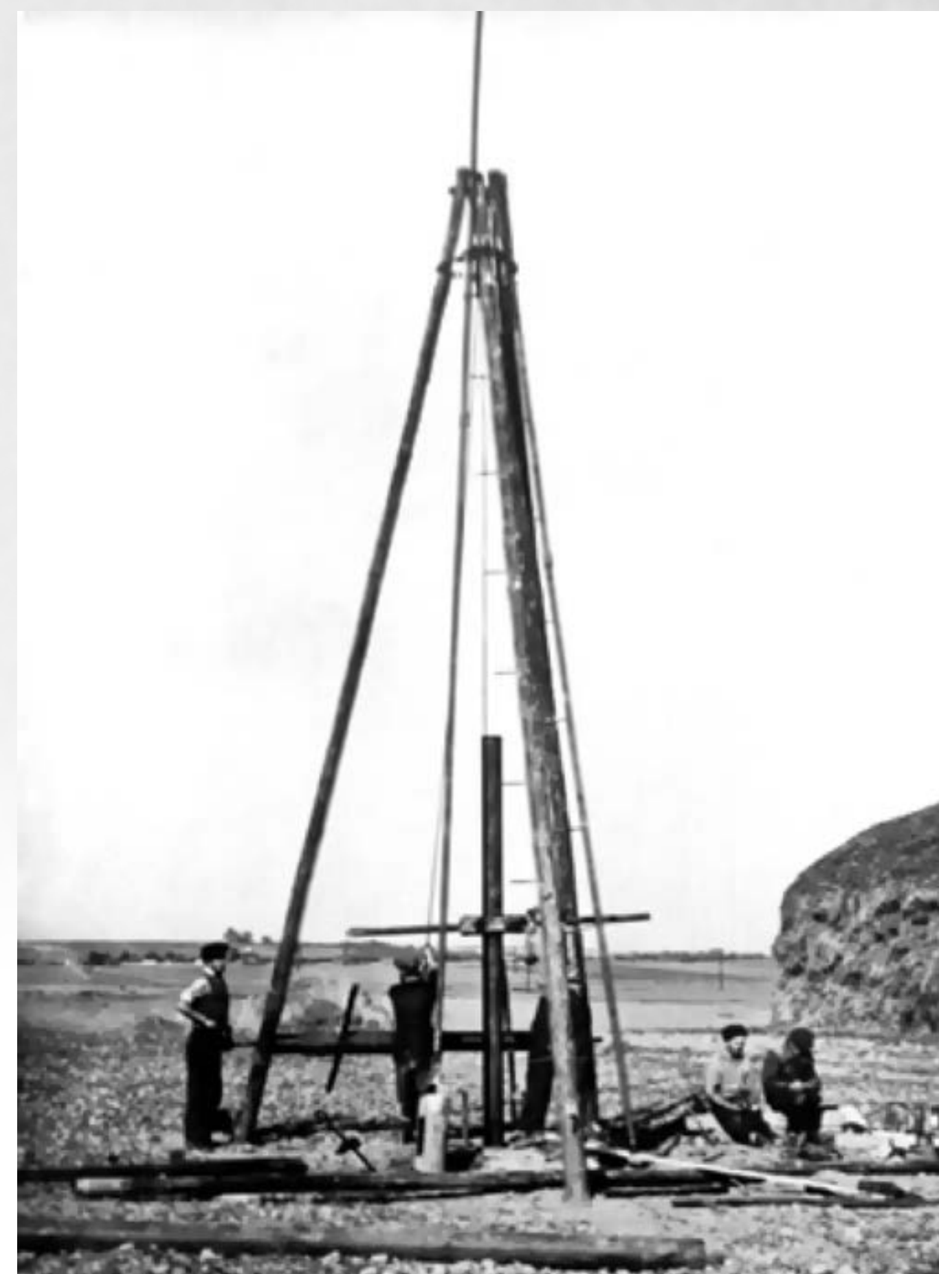
Ręczna wiertnica do badań geologicznych. Fot. Archiwum „Głosu. Tygodnika Nowohuckiego”.
